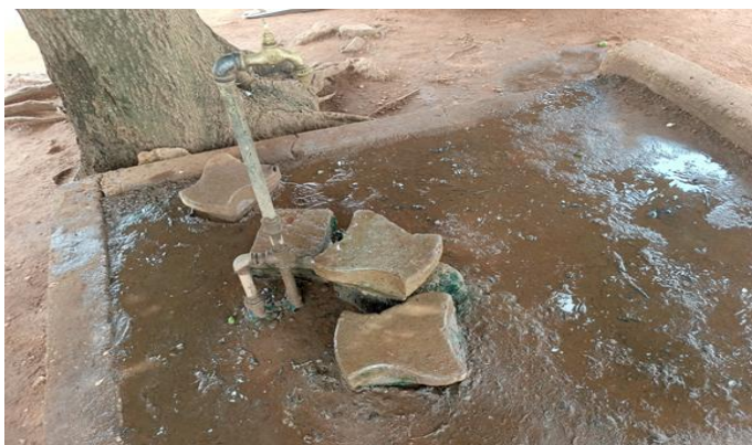
Mauvaises conditions d'hygiène autour d'un point
