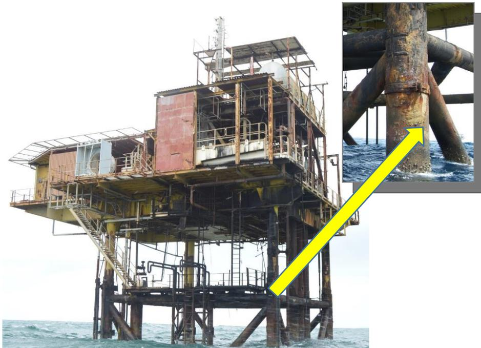
**Photo 21:** Corrosion généralisée de la plateforme de Sèmè, au large des côtes béninoises, avec une perte d'épaisseur visible et la disparition de revêtement (Cliché : MERPMEDER, 2013)
